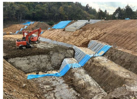
堤体工（ベントナイトシート）施工状況
