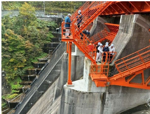
洪水吐ゲート（扉体）を点検歩廊より確認
