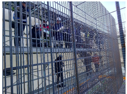
現場研修会の状況(A1橋台)
