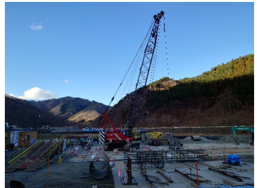
田鎖墓目道路の工事状況
