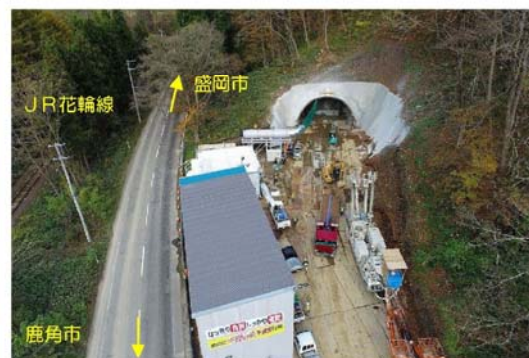
終点側坑口部 (令和6年11月1日時点)
