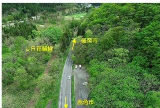
終点側坑口部 (令和6年5月8日時点)
