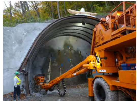
掘削状況(終点側坑口部付近)
