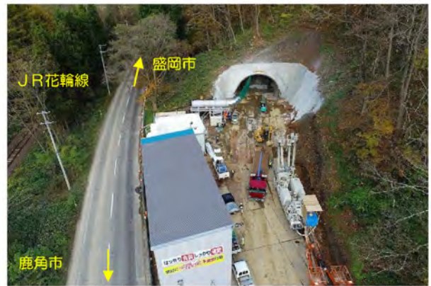
終点側坑口部 (令和6年11月1日時点)
