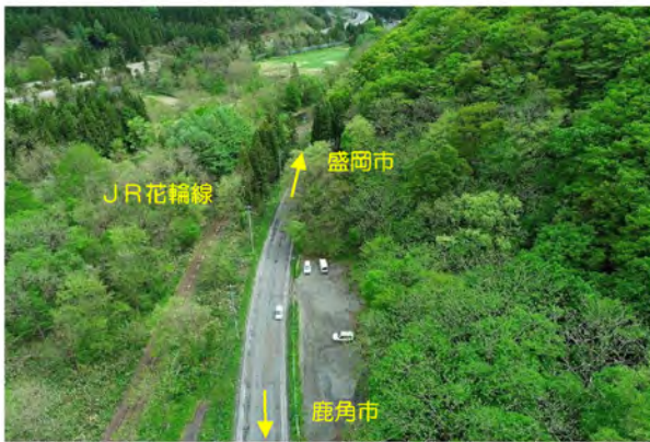
終点側坑口部 (令和6年5月8日時点)
