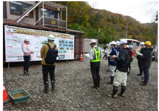
岩手県による工事概要等の説明
