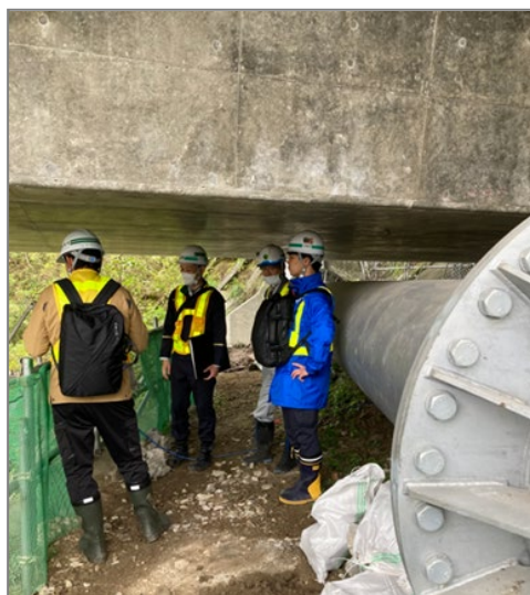
写真 2.視察状況 (橋梁桁下での説明)
