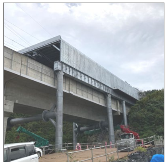
写真 3.川原木トンネル緩衝工全体
