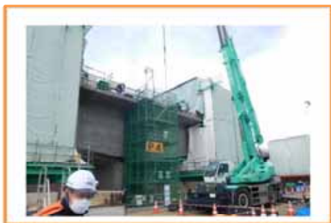
P4 橋脚張り出し
