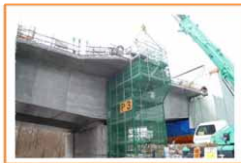
P3 橋脚張り出し
