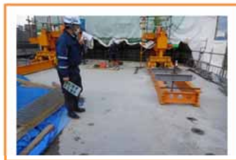
P3 橋脚上の移動作業車
