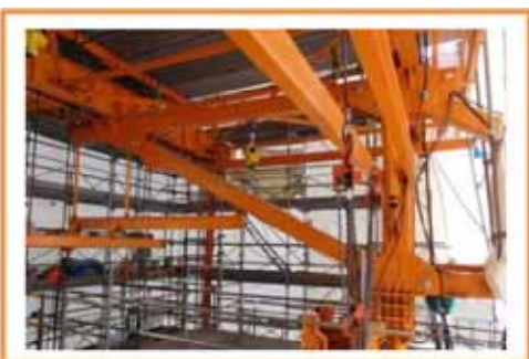
P3 橋脚上の移動作業車
