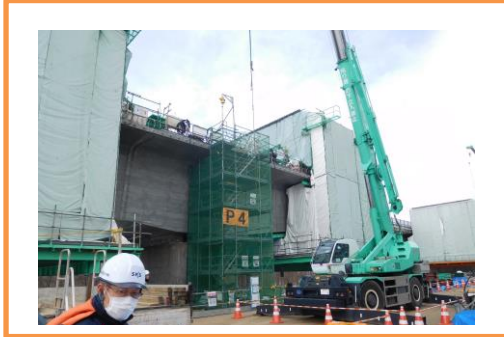
P4 橋脚張り出し
