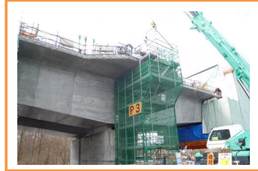
P3 橋脚張り出し
