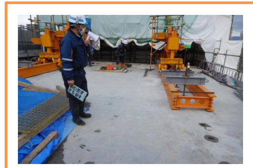
P3 橋脚上の移動作業車
