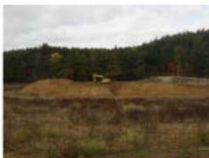
堤体掘削土をストックヤードに運搬
