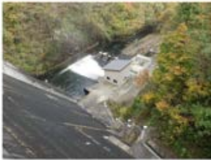
放流施設（令和3年5月竣工）
