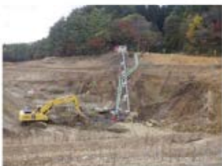
堤体掘削の状況
