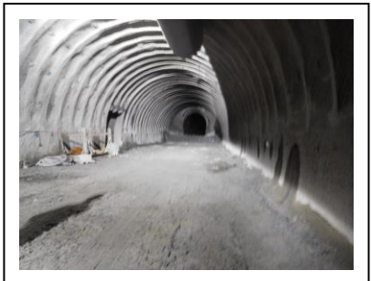
切羽写真 (空洞は既設 J R トンネル)
