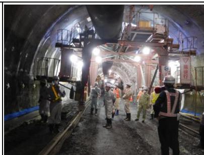
トンネル覆工センター
