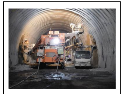
切羽付近サイド拡幅作業
