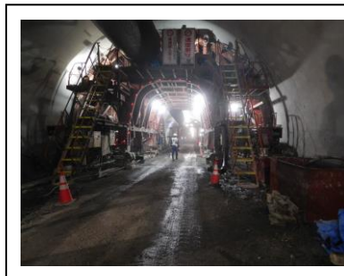
トンネル覆工センター
