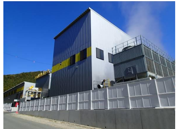
木質バイオマス発電所外観
