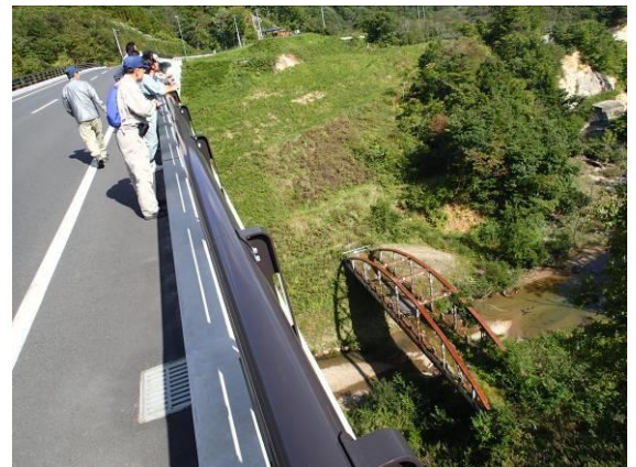
祭時大橋直下の古いトラス橋
