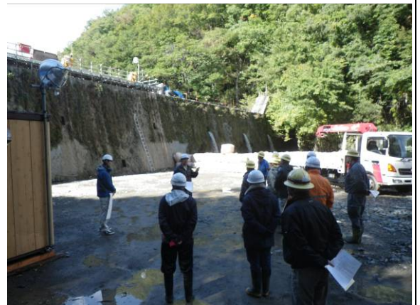
御山川治山えん堤 (補修状況の説明)
