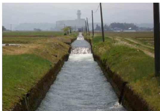
写真 3-1 仁エ門用水路
