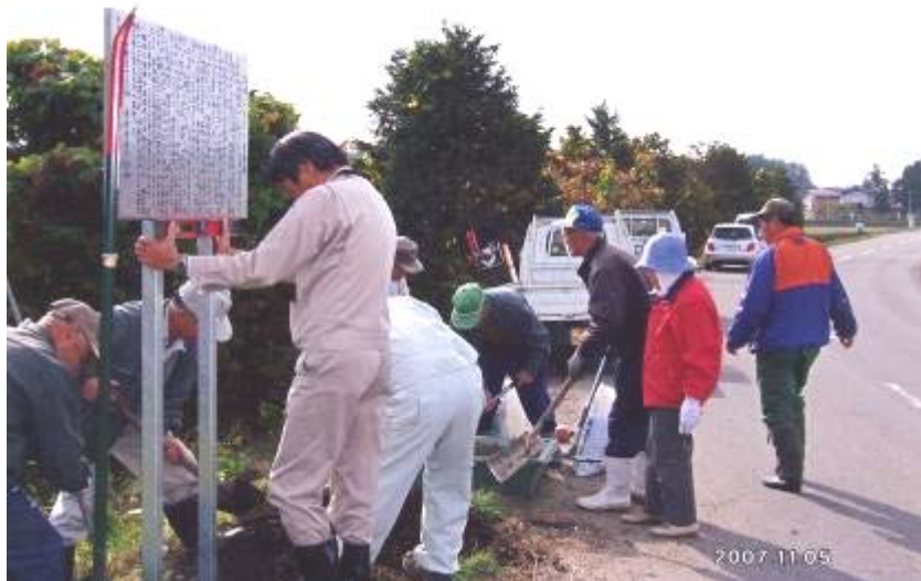
「宝」の案内板設置作業の状況
